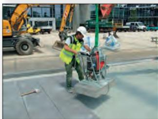
**probst Vakuum-Anbaugerät „QUICKJET QJ-600-E“**
